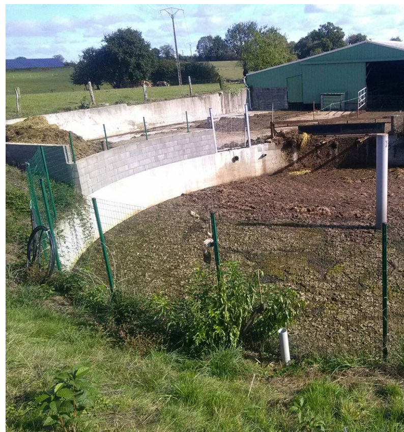
Lagune de stockage (Crédit : FRCUMA Ouest)
